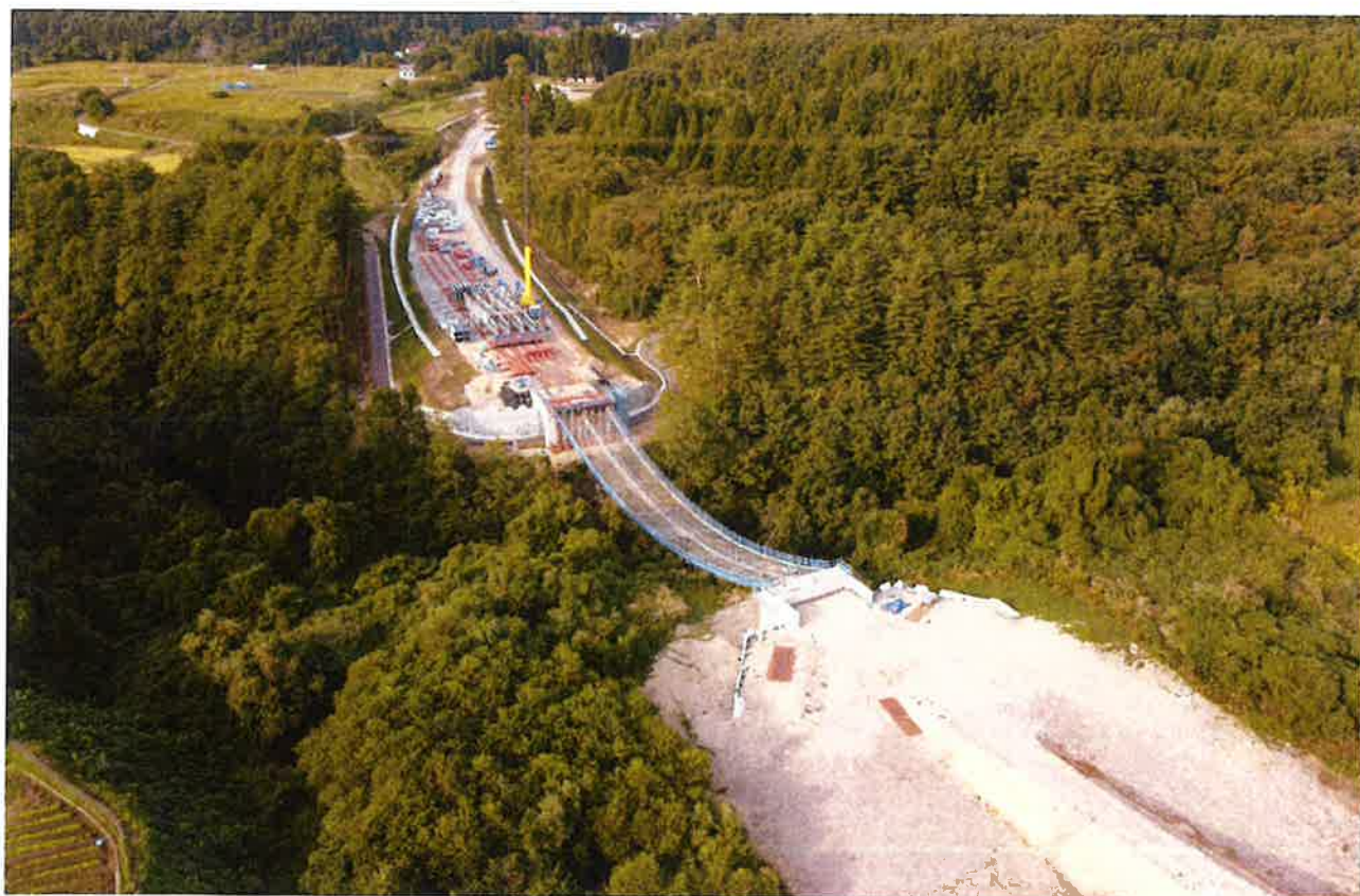
会津縦貫南道路4工区湯野上バイパス 6号橋施工状況
